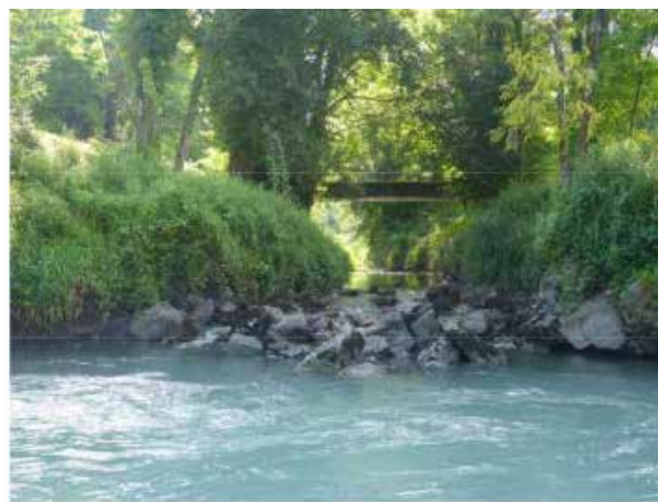
Confluence avant travaux (printemps 2021).
