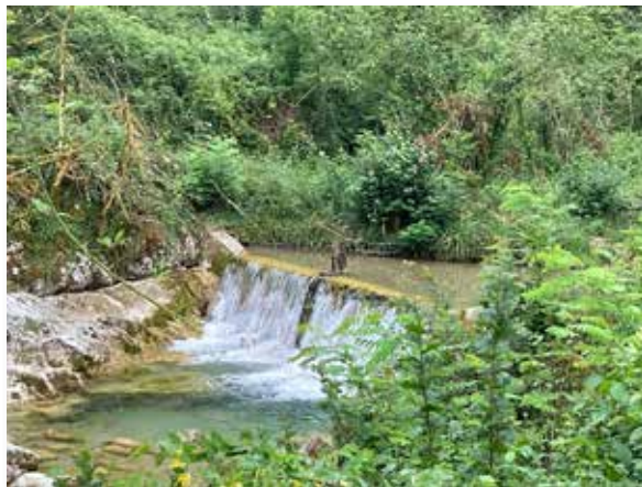
Seuil des Rez sur la Drevenne en 2021 avant travaux
