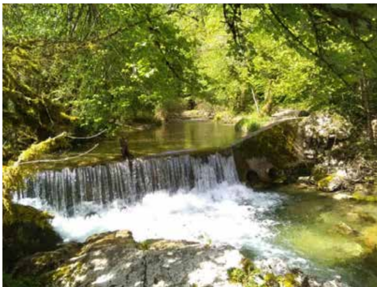
Seuil avant travaux prévus en 2021
