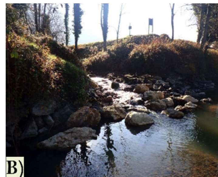
Vue aval de la confluence du Canal de St-Quentin : avant travaux par hautes eaux (A), après travaux par basses eaux (B)
